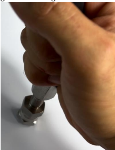
Abbildung 11 - Eindrücken des Nippels in den Schlauch mit vormontierter Fassung
